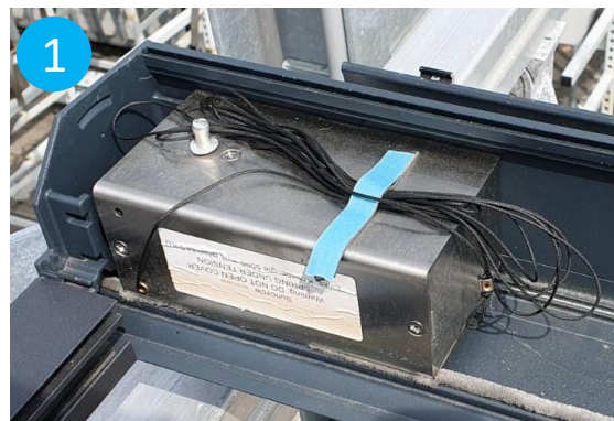
Verwijder onderkap van de veerkast cassette.
